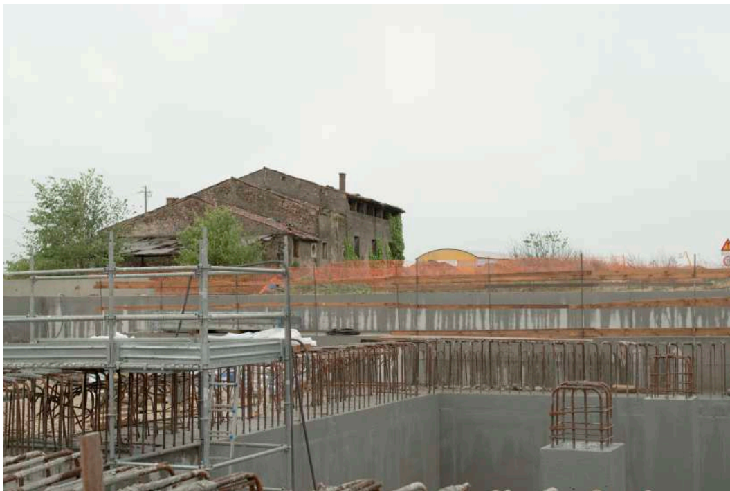
Figura 3 | Casa rurale abbandonata e, in primo piano, uno dei cantieri della linea Verona-Vicenza (fonte: Silvia Marchesini, 2024)
