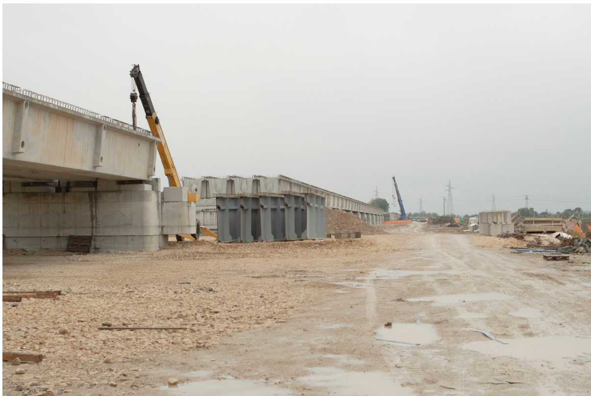
Immagine 3. Sopralluogo al cantiere del viadotto, S. Martino Buon Albergo
