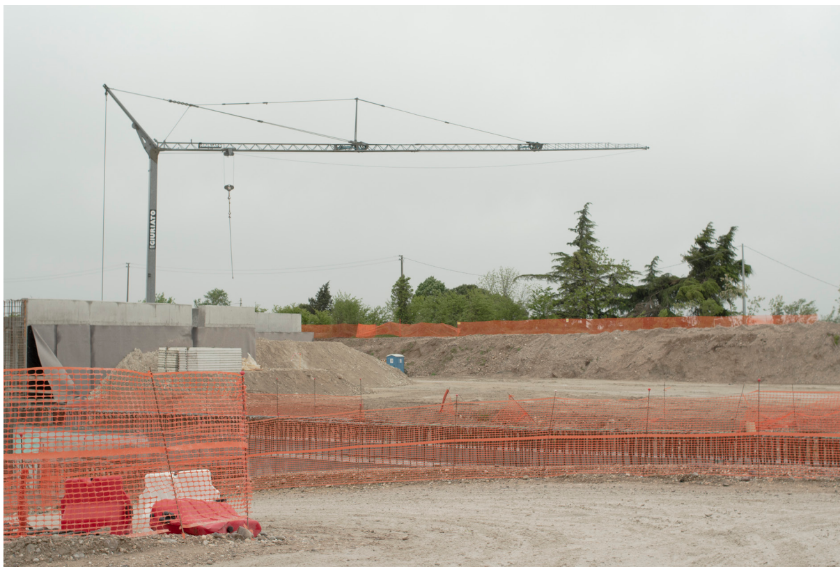
immagine 1. Sopralluogo al cantiere GA01, galleria artificiale, S. Martino Buon Albergo
