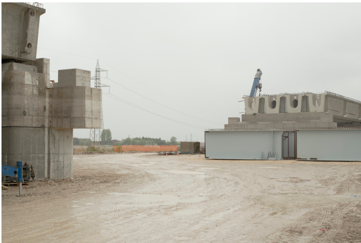
Immagine 4. Sopralluogo al cantiere del viadotto, S. Martino Buon Albergo
