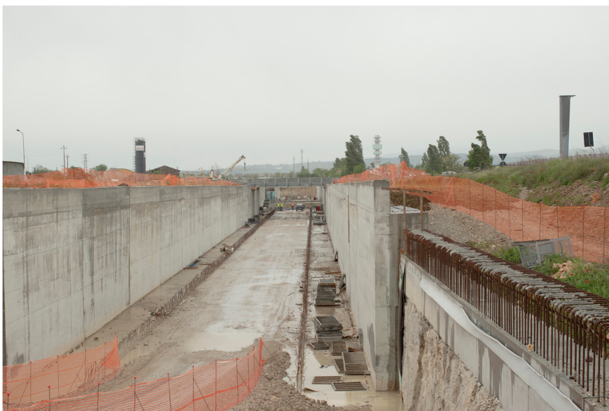
immagine 2. Sopralluogo al cantiere GA01, galleria artificiale, S. Martino Buon Albergo
